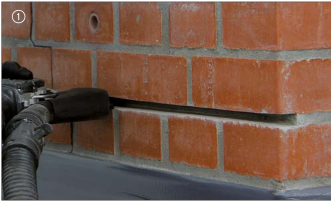
1 Fuge mit AS170 Stein- und Fugensäge aussägen Scrier le joint avec la Scie à brique et mortier AS170
