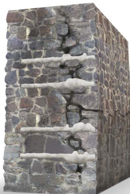
Anbindung abgelöster Mauerwerkschalen Raccordement des murs séparés
