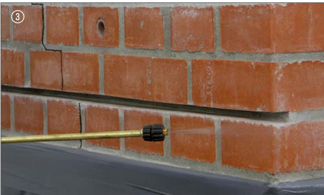
3 Fuge vornässen | Mouiller le joint
