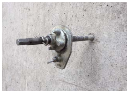
Anwendungsbeispiel: Abdichten des Bohrloches nach Einbringen eines Ankers | Exemple d'application: Etanchéité du trou de forage après l'insertion d'un ancrage
