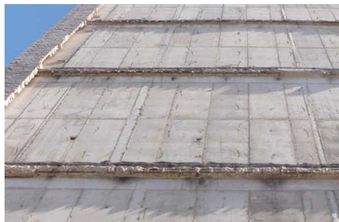
Vormauerschale komplett abgelöst; Drahtanker korrodiert | Mur de parement complètement détaché; ancre métallique corrodée
