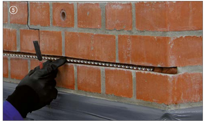
5 Spiralanker setzen | Placer les tirants hélicoïdaux
