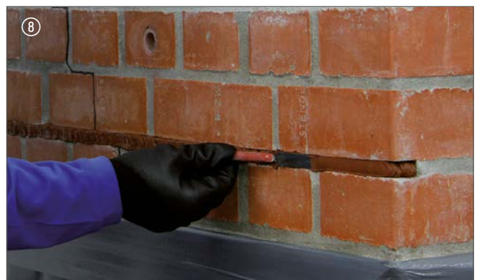
8 DESOI Spiralanker glattstreichen | Lisser le mortier d'ancrage
