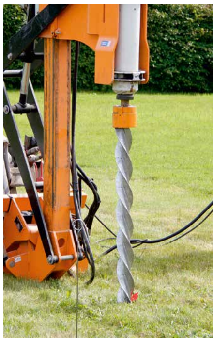
Einrammen der Gewindepfähle Enfoncer les pieux
