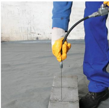
**Injection de fissure avec aiguille de pressage**
