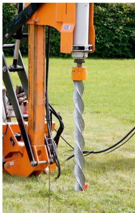
Einrammen der Gewindepfähle Enfonceur les pieux
