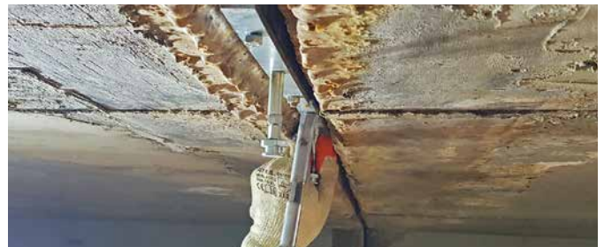
DESOI Quick Seal über das Anzugsrohr spannen | Tendez le joint rapide DESOI sur le tube de traction.
