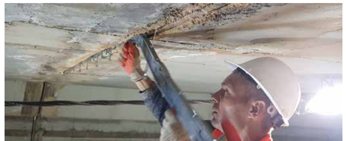
Nach Aushärten des Füllstoffes DESOI Quick Seal einfach entfernen Après le durcissement du mastic, il suffit d'enlever le joint rapide DESOI.
