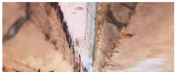
Erfolgreiche Injektion der Fuge | Injection réussie de l'articulation
