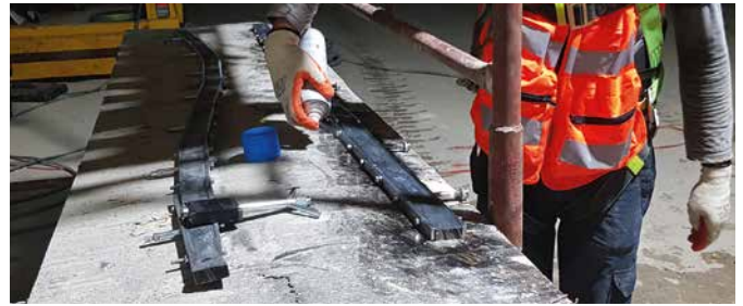
Auftragen des Schutzfilms mit Silikon-Spray | Application du film de protection avec un spray de silicone
