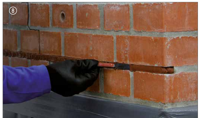
8 DESOI Spiralanker glattstreichen | Lisser le mortier d'ancrage
