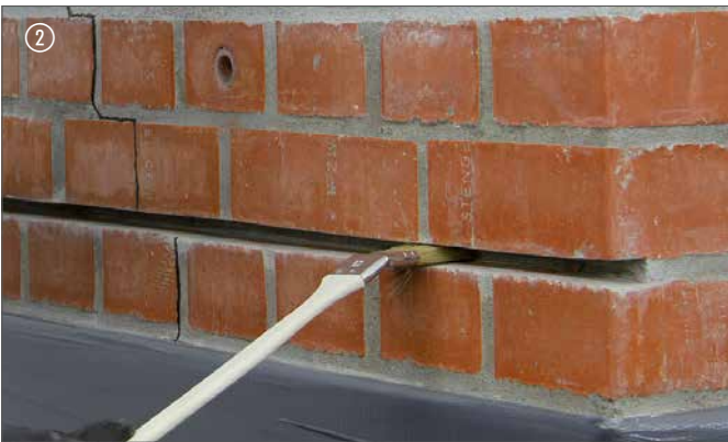
2 Fuge reinigen | Nettoyer le joint
