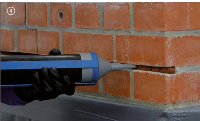
4 Erste Lage DESOI Spiralanker einbringen | Remplir le joint d'une couche de mortier d'ancrage
