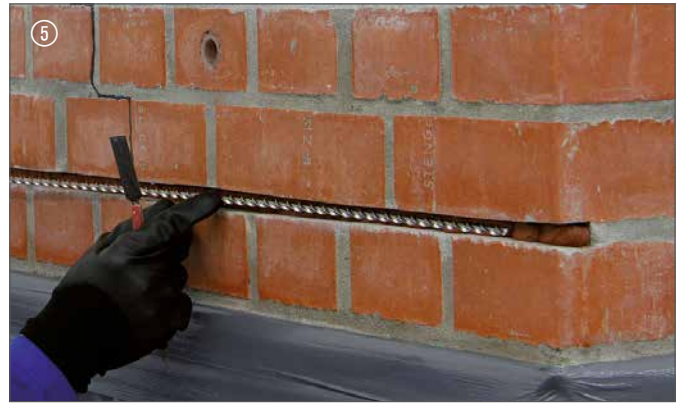
5 Spiralanker setzen | Placer les tirants hélicoïdaux
