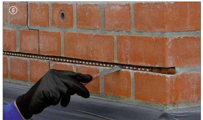
6 DESOI Spiralanker in den Mörtel drücken Encastrier les tirants hélicoïdaux DESOI dans le mortier d'ancrage
